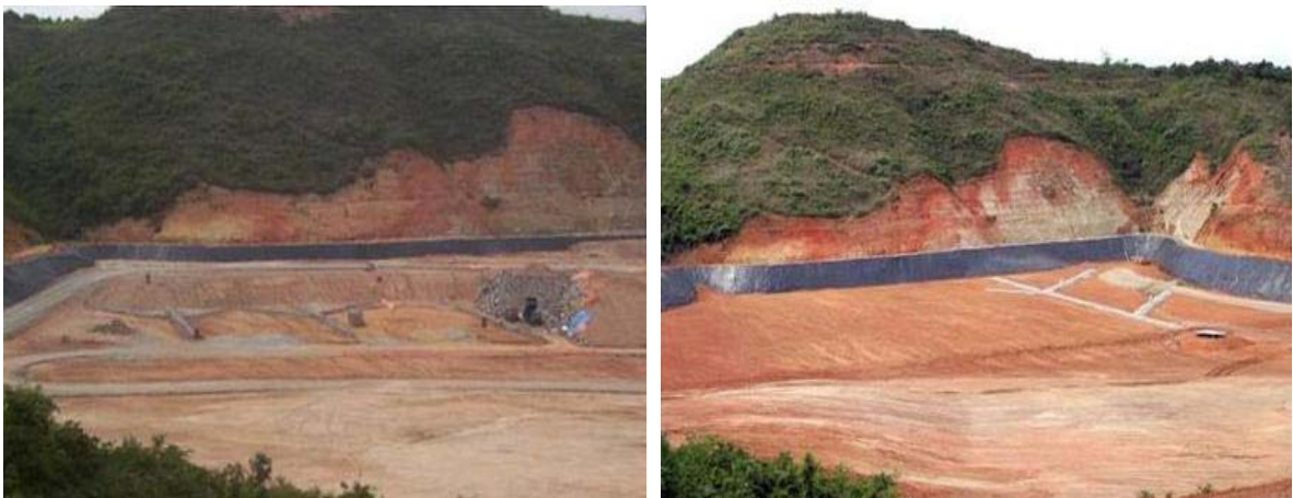
Figura 6.12.4.3-7: Drenagem de percolados na base, sobre o liner .
